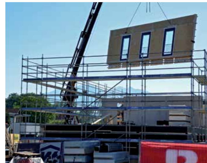
Die Baustelle im Juni. | Foto: Benzer
